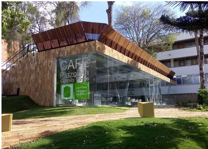
Bajos del Complejo Camilo Torres - UIS
